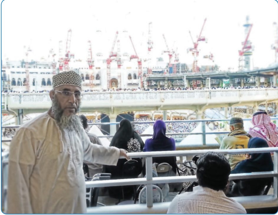
منظر للكعبة المُشرفة من الطابق الثاني، وتظهر الرافعات العديدة المستخدمة في مشروع توسعة الحرم
